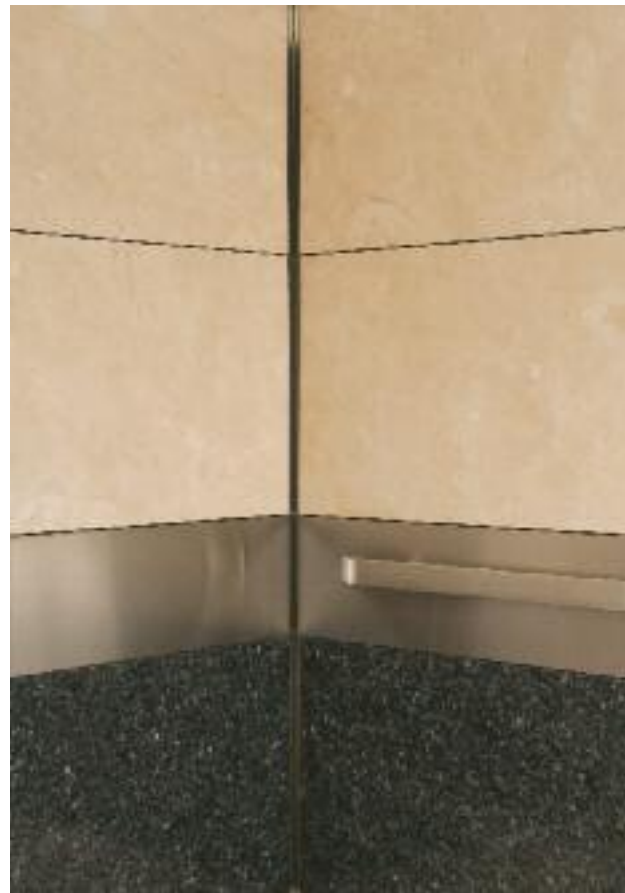
Milano I: corner detail
